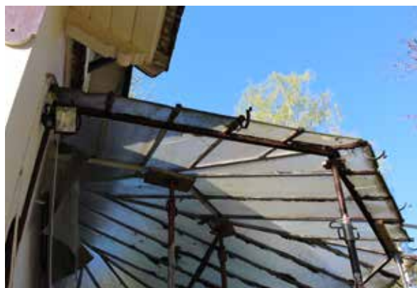
Abstützung der Dachkonstruktion
