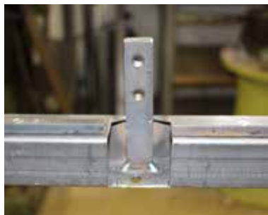
Untergurt mit Pfostenanschluss
