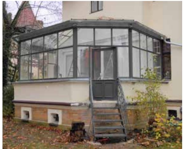
Restaurierter Wintergarten von Westen
